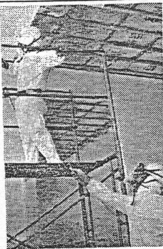
牧港住宅エリアの天井の石綿板除去作業 30日午後3時
