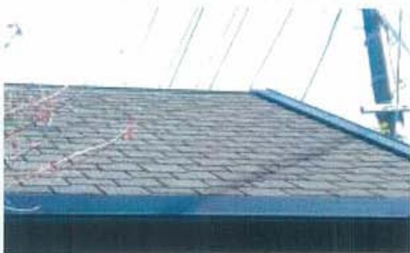
石綿含有住宅化粧用スレート（屋根）
