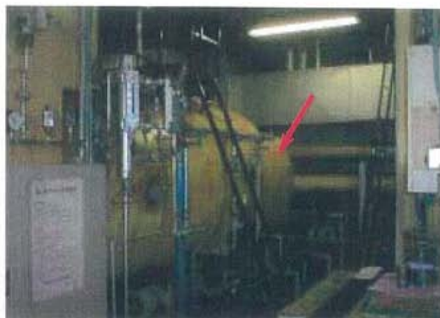
石綿含有保温材（ボイラ外周部）
