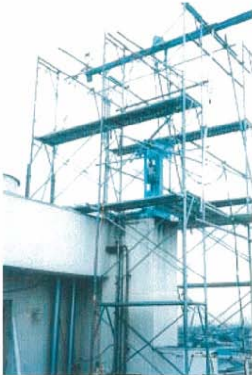
煙突上部及び灰出し口を隔離養生
