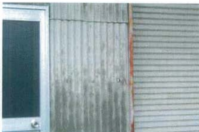
石綿スレート（屋根・外壁）
