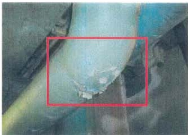
石綿含有保温材（配管曲がり部）
