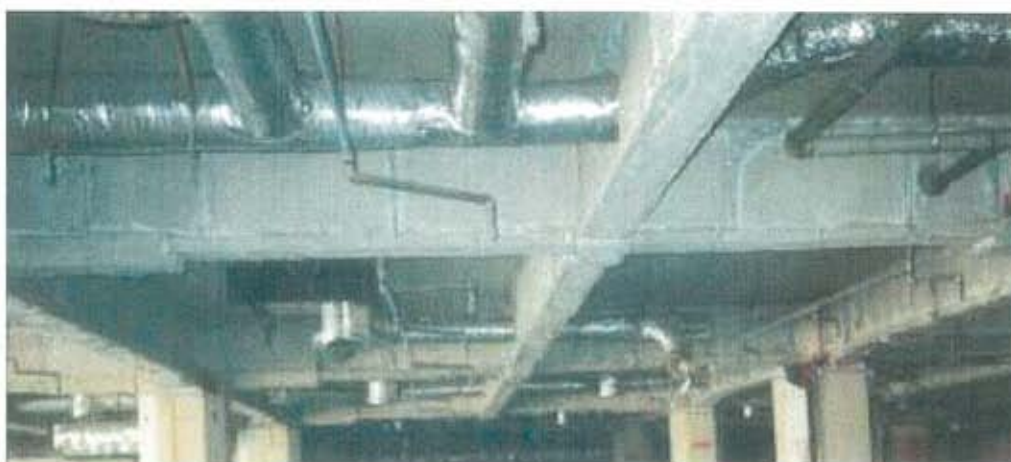
耐火被覆用石綿含有ケイ酸カルシウム板（2種）（S造の柱・梁）
