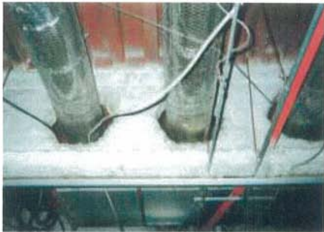
耐火被覆用吹付け石綿・石綿含有吹付けロックウール (S造の柱・梁)
