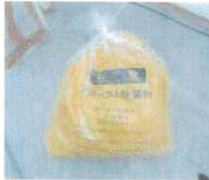
アスベスト廃棄物の二重袋詰
