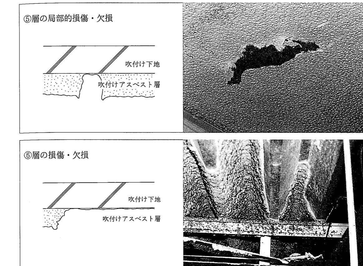
図表3-12 吹付け石綿の劣化損傷状態のモデル図（その2）
