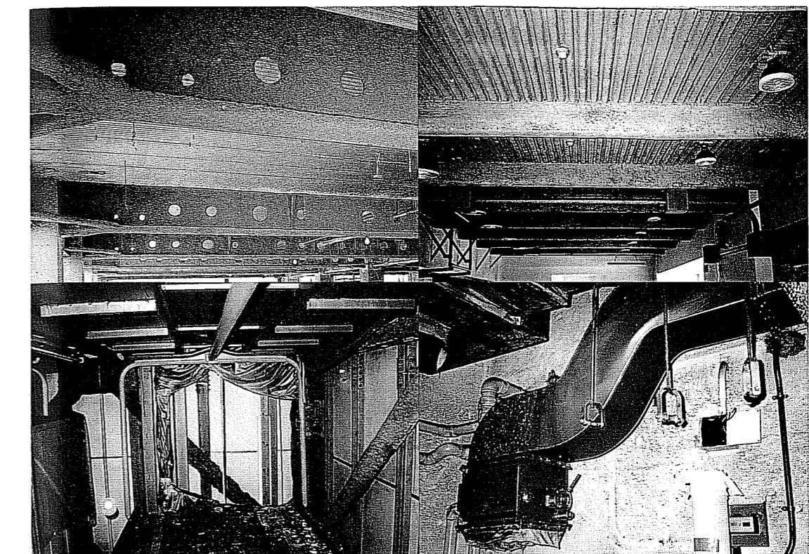
図表3-5 吹付け石綿の施工例
